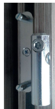
DETAIL TRNŮ PROTI VYSAZENÍ
